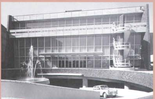
昭和40年2月、コンサートホールとして開業
