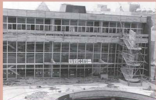
昭和39(1964)年、工事が進む公会堂
